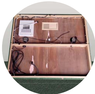
Náhled stropu z vrchní části.
