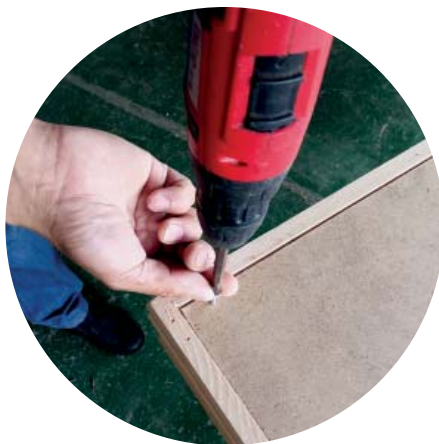
Montáž krytu stropu
